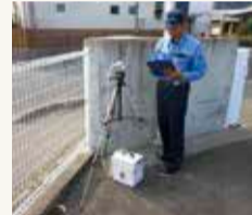
石綿粉じん測定
