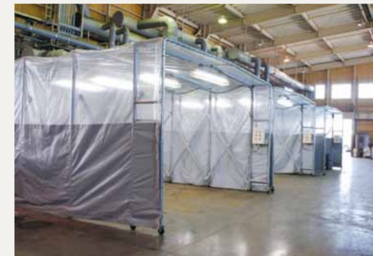
分水・蒸工場にブース型排気装置を設置
