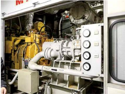
アンモニアを冷媒としているノンフロン冷凍機
