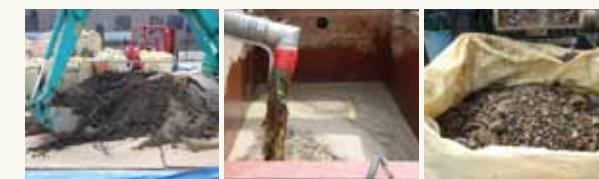
汚染土壌 脱水後、洗浄液は再利用 洗浄済み土壌（埋め戻し）
