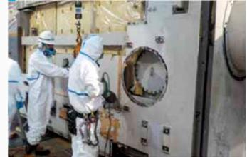
微量PCBに汚染した小型の電気機器の処分はもちろんのこと、現地での解体や抜油が必要な中・大型の電気機器の解体撤去、処理も行っています。
