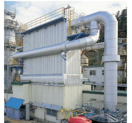
③集じん装置／ガス冷却塔に水を噴霧し、ガスを急冷します。そこに消石灰を投入し、酸性ガスを中和し、その反応生成物(ばいじん)を集じん装置で捕集します。
