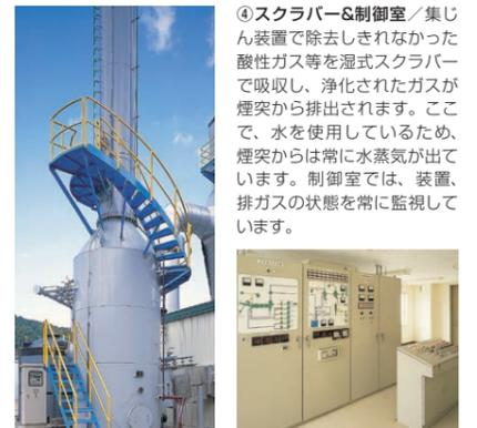
④スクラバー&制御室／集じん装置で除去しきれなかった酸性ガス等を湿式スクラバーで吸収し、浄化されたガスが煙突から排出されます。ここで、水を使用しているため、煙突からは常に水蒸気が出ています。制御室では、装置、排ガスの状態を常に監視しています。
