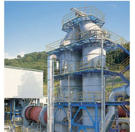
②キルン&二次燃焼炉／キルン出口のガス温度は800～850℃、二次燃焼室出口で850～900℃にて運転します。また、同時に空気量(酸素量)の制御も必要となります。
